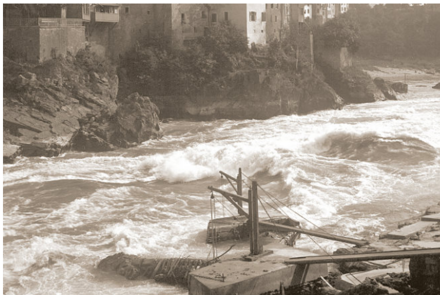
Die „Äussere Reuse“ und die „Mittlere Reuse“ gegenüber der Totenwage wurden im 19. Jahrhundert bereits auf betonierte Sockel montiert.
